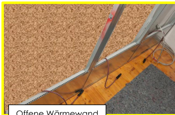
Offene Wärmewand mit Innendämmung
